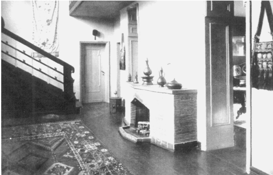
Abb. 22. Kamin in der Wohndiele (Klinker mit phantasievollem Fugenschnitt)
