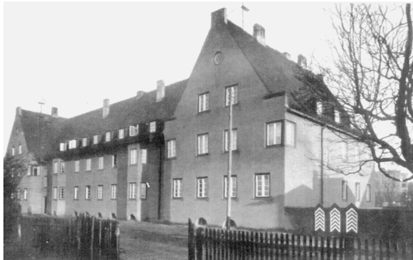
Abb. 19. Beamtenwohnhaus in Schlawe. Ein zweigeschossiges Gebäude mit ausgebautem Dachgeschoss, flächige Fassade zwischen zwei Giebeln mit stark ausgebildeten „Schultern“ und knapper Giebelbekrönung
