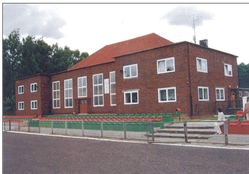
B. Schlawe. Turnhalle. Foto 2007 Sławno. Sala gimnastyczna. Fot. 2007
